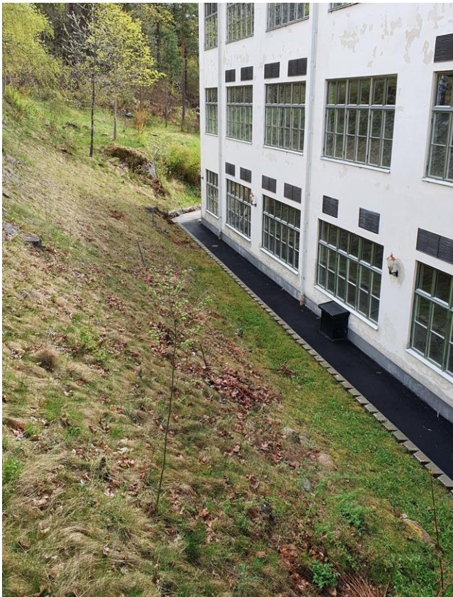
Figur 9. Foto av Torshagshuset som visar att stuprören leds direkt ned till ledningsnät i marken.
