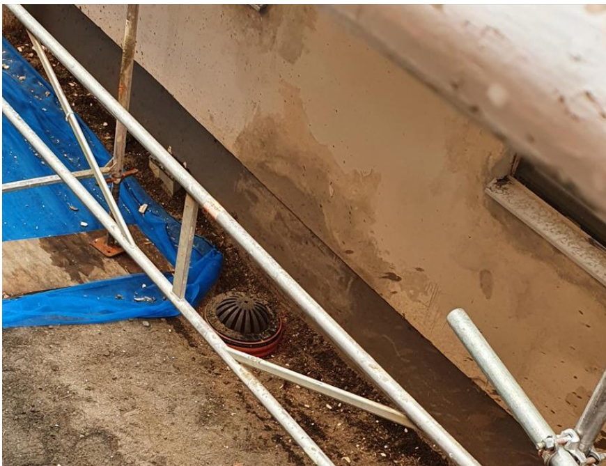
Figur 25. En av flera kupolbrunnar mellan de befintliga fabriksbyggnaderna.
