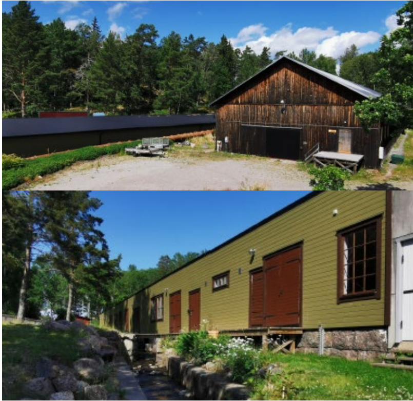
Figur 16. Övre bilden visar ladugårdsbyggnaden som finns norr om Torshagshuset. Nedre bilden visar en av ekonomibygnaderna som finns inom planområdet. Foto: Hanna Domfors, 2020.
