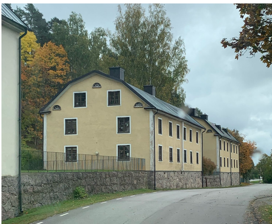
Figur 21. Översta bilden visar en av arbetarbostäderna. Nedersta bilden är tagen från Katrineholmsvägen och visar arbetarbostäderna och den höga grunden. Foto: Fanny Germer, 2022-09-14.
