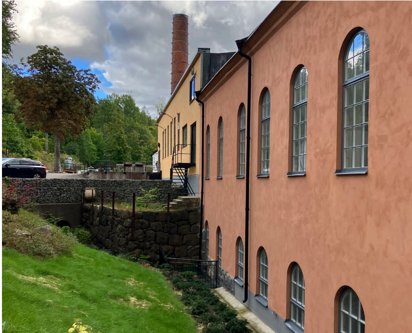
Figur 25. Bilden ovan visar fabriksbyggnaden norr om Torshagshuset. Foto: Fanny Germer, 2022-09-14.
