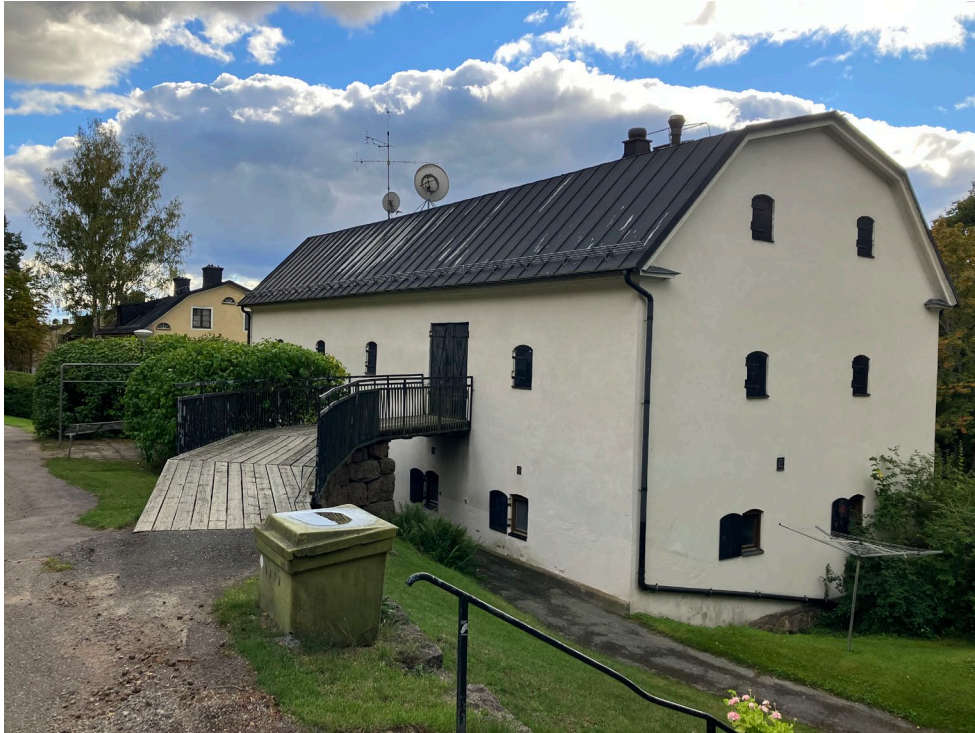
Figur 22. Bilden ovan visar magasinet och rännesbron. Foto: Fanny Germer, 2022-09-14.
