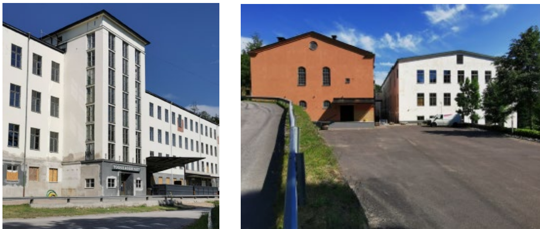
Figur 15. Till vänster den monumentala fasaden av huvudbyggnaden mot Katrineholmsvägen. Till höger Vigognespinneriet med orange fasad, från 1870-talet och huvudbyggnaden som uppfördes 1940–1950 talet. Foto: Hanna Domfors, Kulturmiljöunderlag, 2020.
