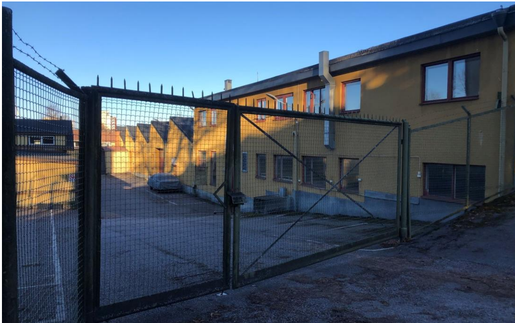
Figur 26. Fasad mot gården i väster. Bild: Ida Hansson, februari 2022.
