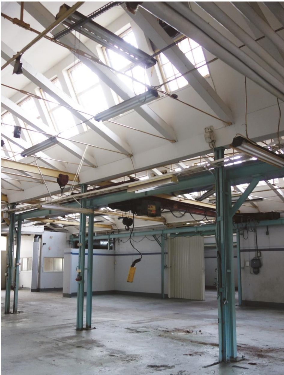
Figur 25. Interiör med betonggjutet golv och synlig konstruktion. Sågtandstakets fönster är placerade i det typiska norrläget och utrustade med småspröjsade ursprungliga bågar. Bild: Fredriksson arkitektkontor, 2020.
