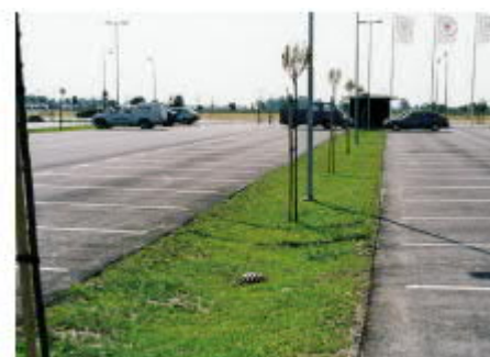
Figur 47. Till vänster: Principskiss av infiltrationsstråk. Till höger: Infiltrationsstråk vid parkeringsyta. Bilder hämtade från Stockholm vatten och avfall, 2017.
