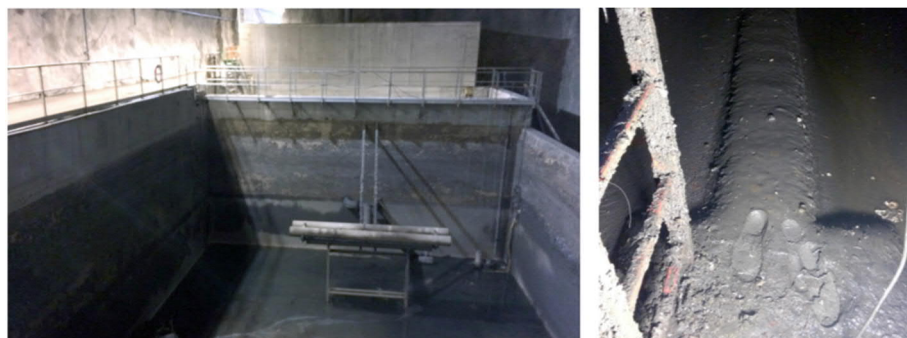
Figur 44. Exempel på ett större avsättningsmagasin. Foto Stockholm Vatten.
