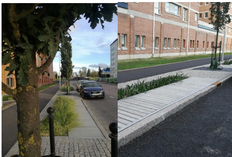
Figur 33. Växtbäddar och trädplanteringar i skelettjordar längs Packhusgatan i Karlstad. Foto: Sofia Hallerbäck
