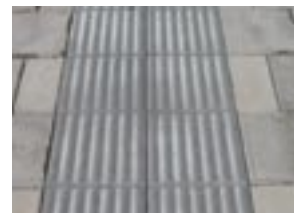
Sinusplatta anger riktning
