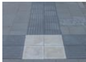
Valplatta i ledyta anger när ett ledstråk byter riktning
