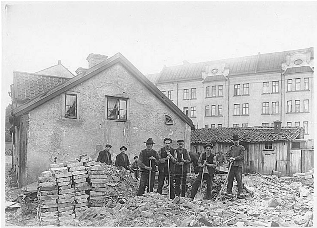
Figur 9. Arbetare som river bostadshus i Triangeln. Det handhamrade teglet staplas för att återanvändas till den inflyttande industrin. © Norrköpings statsarkiv, fotograf: Gustaf Lindberg 1925.
