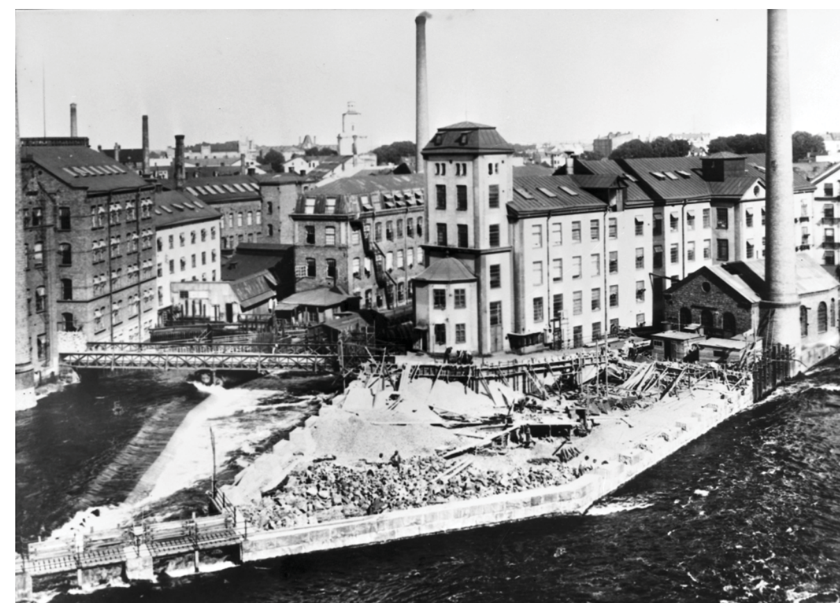
Laxholmen vid grundläggningen av byggnaden Strykjärnet.
