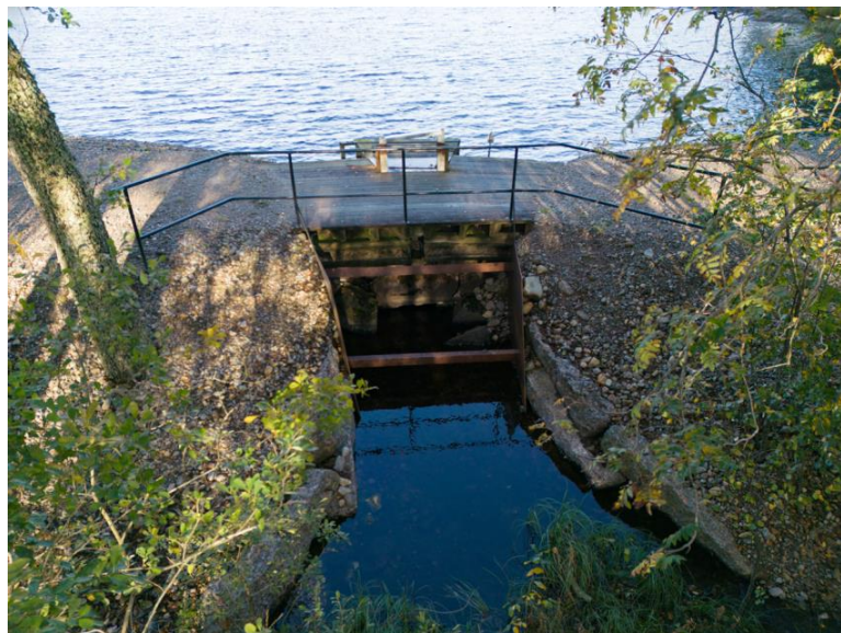
Figur 4. Nedströmssida av utskovet
