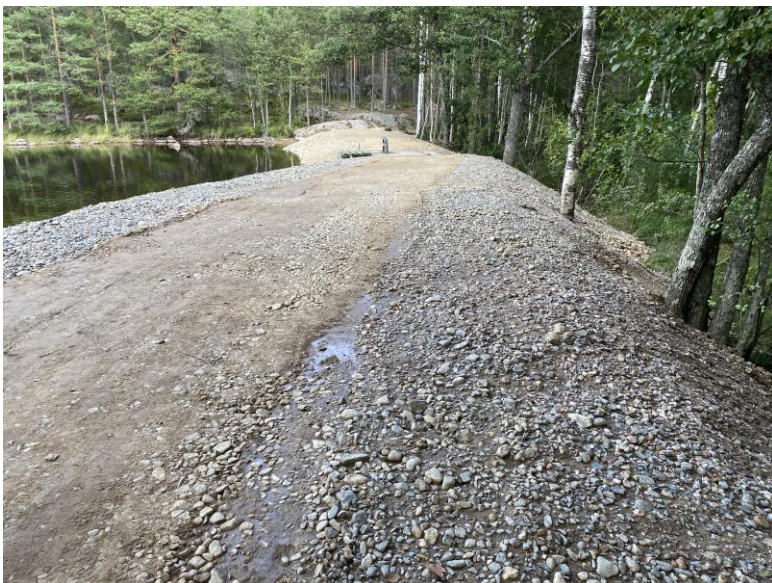
Figur 3. Fyllnadsdamm med utskov, vy från sydväst.
