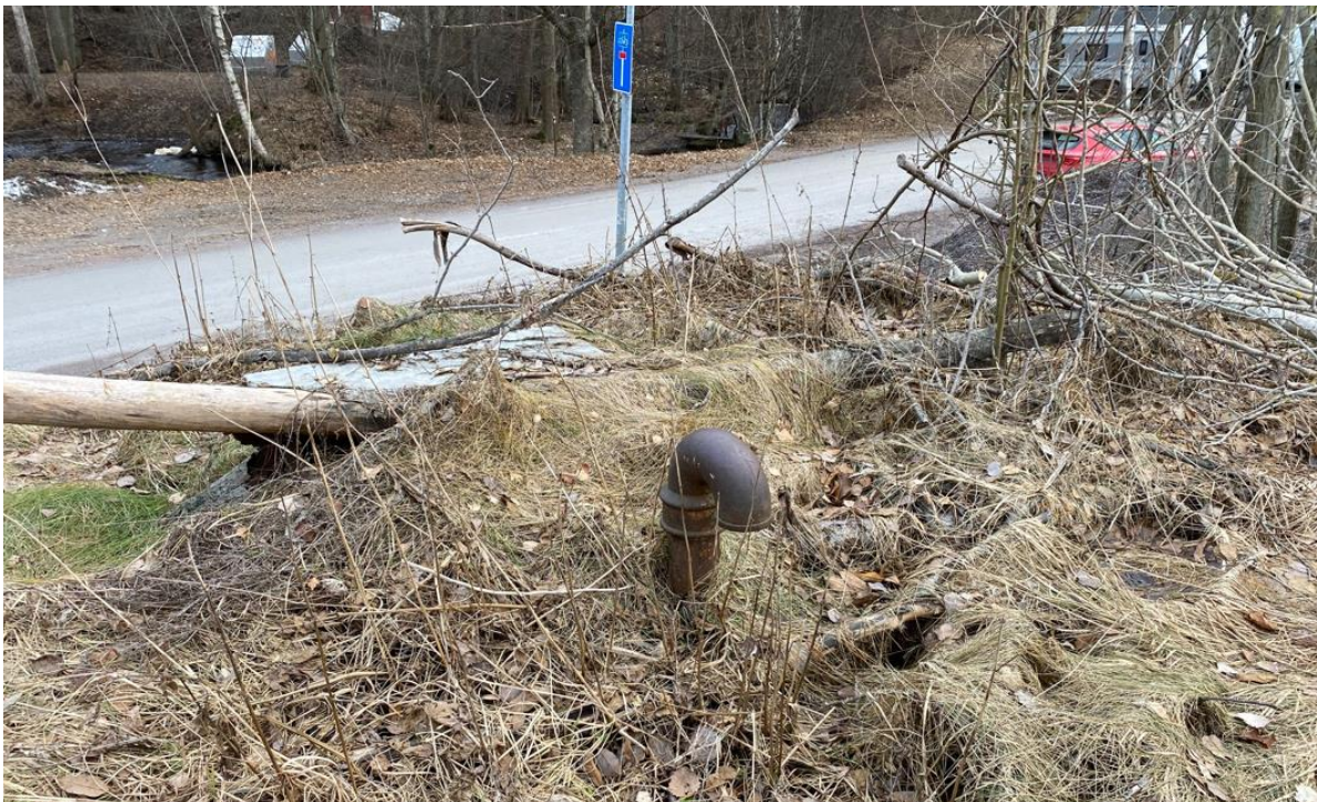
Bild 5. Dagvattenytan. Anläggningen på toppen av kullen. Ett metallock och ett luftningsrör är synlig i markytan.
