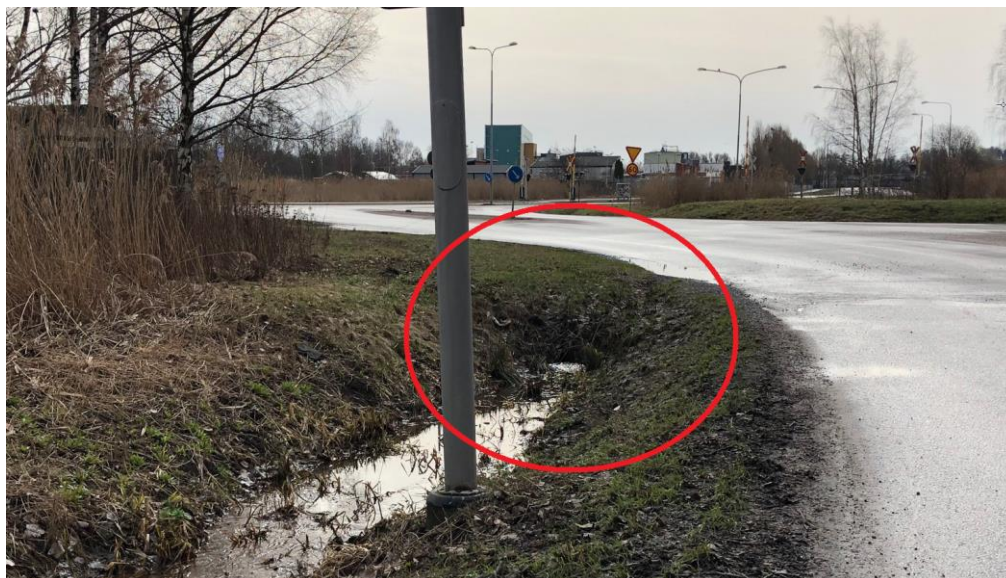
Figur 14 - Utlopp från befintliga D500-ledningen vid Kommendantvägen.
