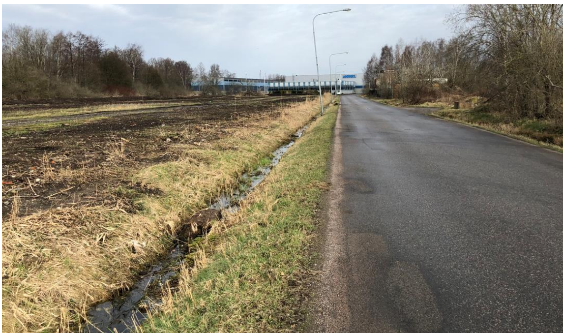
Figur 10 – Befintlig avvattning vid Jungmansgatan. Vy norrut.
