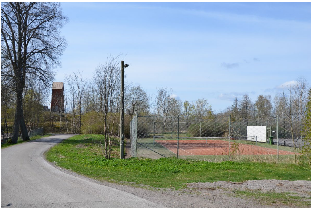
Figur 9. I bilden syns befintliga tennisbanor och den äldre transformatorstationen, strax sydväst om planområdet. Källa: Carlstedt Arkitekter AB.
